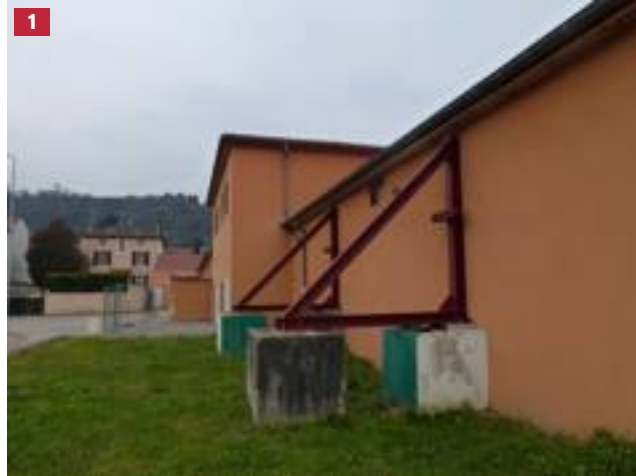
1 Des étais de confortement au dos de la galerie marchande. Photo S. Majou
